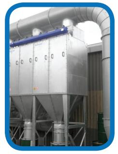
PULSE JET CARTRIDGE DUST COLLECTOR
